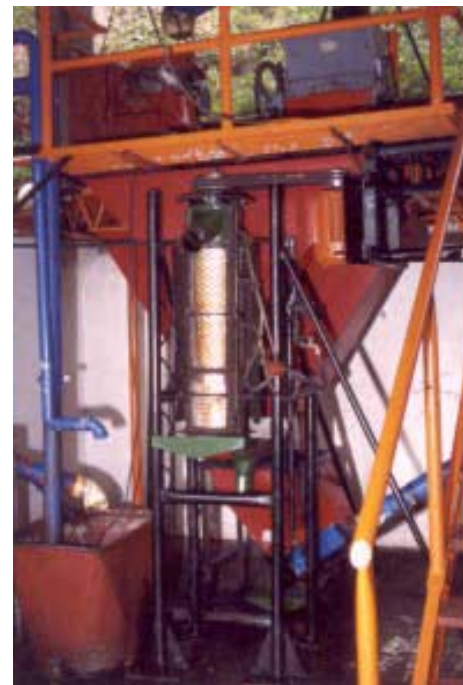
Figura 7. Módulo BECOLSUB 3.000 construido en CENICAFÉ.
